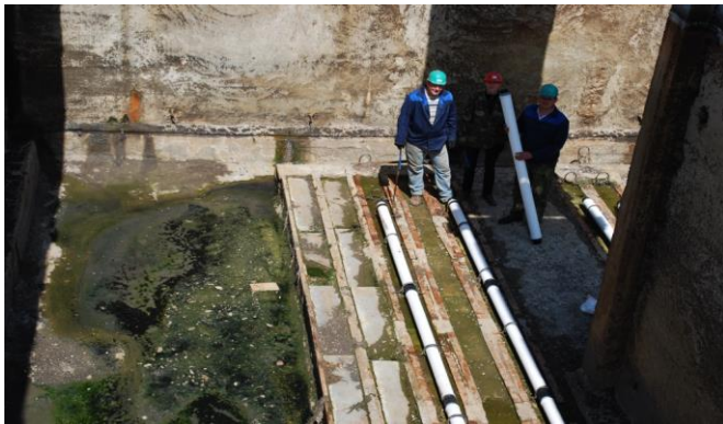
Процес встановлення аераторів «АКВА-ЛАЙН-М» в аеротенку № 5 бригадою слюсарів-ремонтників цеху очисних споруд каналізації підприємства
